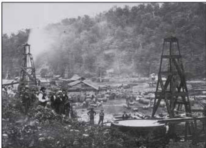
Primer pozo industrial perforado (Titusville, 1859)
