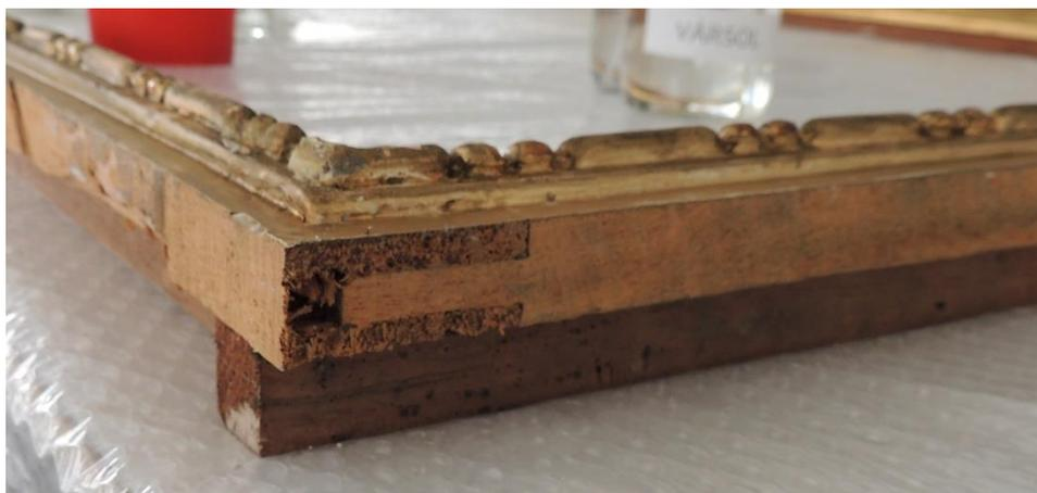
**Fotografía No. 24.** Marco. Detalle de los cantos laterales sin acabado y sistema de ensamble por caja y espigo
