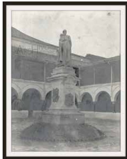
Imágenes tomadas en 1909 cuando se erigió la estatua en honor al Fundador Fray Cristóbal de Torres, en el centro del patio del Claustro.
